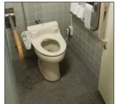
【現庁舎トイレ】
