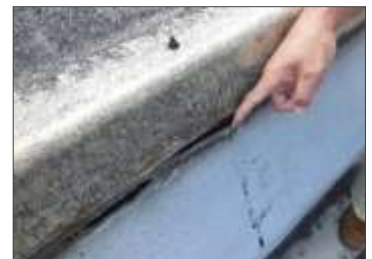
【屋上防水の立上り】
