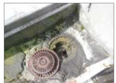
【屋上の排水口】
