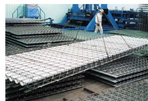
鉄筋先組型枠工法
